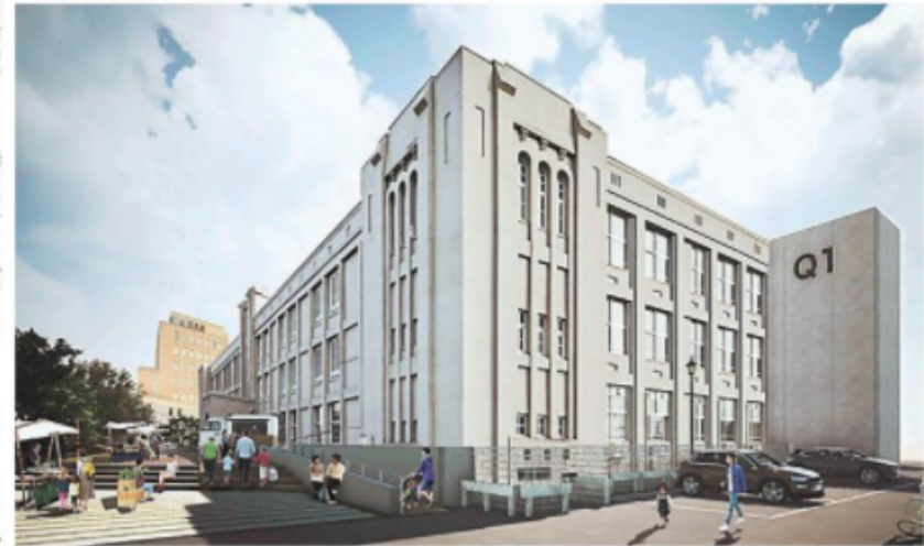
センター改修後のイメージ。建物西側にエレベーターが設置される(山形市提供)
